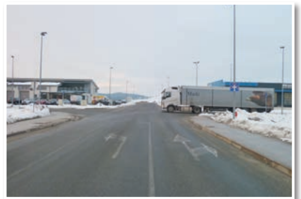
Začetek navezovalne ceste v industrijski coni
