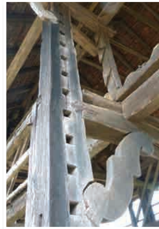
Čolnikov kozolec pred demontažo, 2. 9. 2015, spada med največje v Sloveniji in meri v dolžino 30 m, v širino 10 m in v višino skoraj 15 m.
