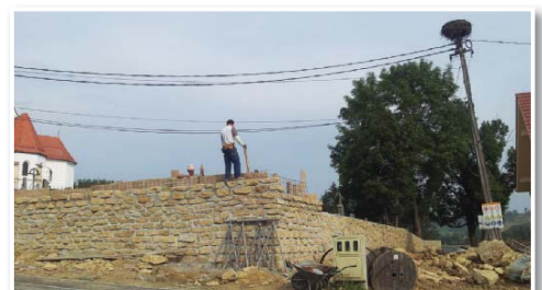
Novo obzidje okoli starega pokopališča v Jurovskem Dolu že dobiva končno podobo in bo skupaj z novim kulturnim domom prihodnje leto dajalo Jurovskem Dolu prijeten videz ob vstopu v naselje.
