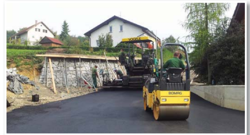
Projekt obnove vodovoda in izgradnje kanalizacije je tik pred koncem. Minuli teden so izvajalci opravljali še zadnja asfaltiranja cest.
