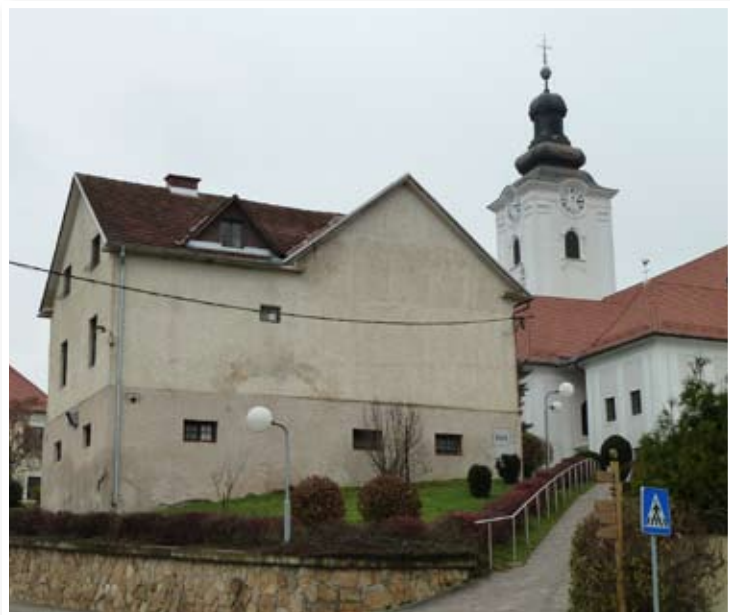
Kulturni dom čaka na obnovo
